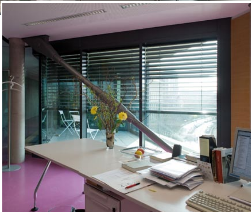
Neben Innenrollos werden zur Beschattung auch Außenjalousien eingesetzt.
