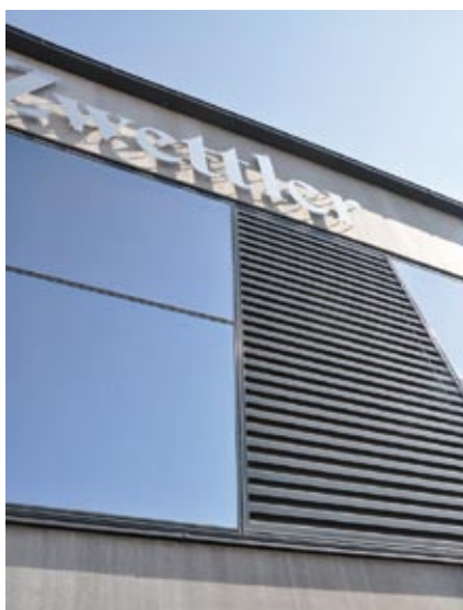
Das Lamellenwandsystem besteht aus stranggepressten Aluminium-Profilen.
